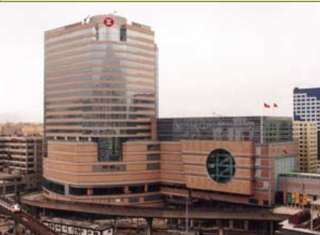
位於九龍灣的地鐵公司總部 Headquarters of MTR Corporation in Kowloon Bay
